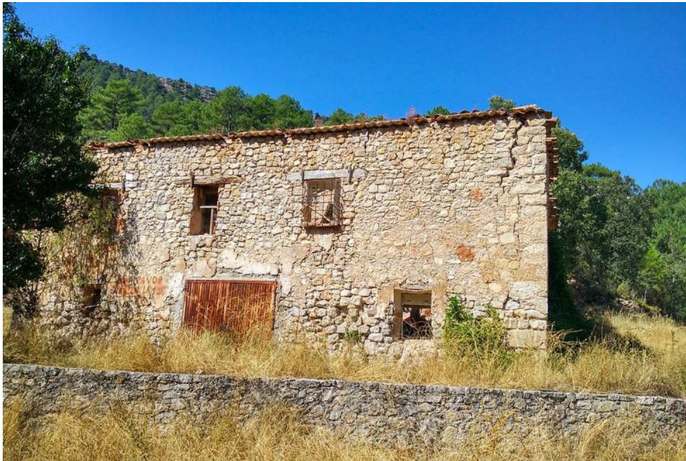
FOTOGRAFIA 12. PARADA 9 Edificio principal de las Salinas de la Inesperada. Ocentejo
