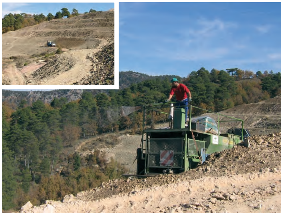
Imágenes de las labores de hidrosiembra realizadas en El Machorro, como parte de las labores de restauración ambiental de antiguas minas de caolín.
